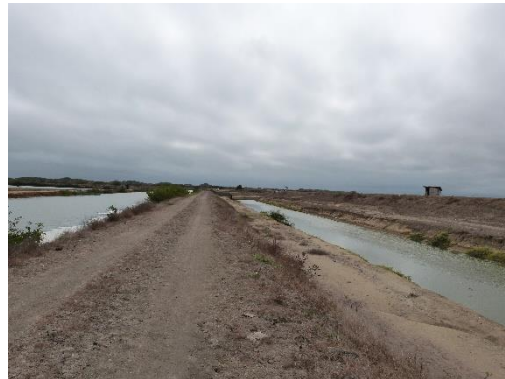
Fotografía No. 55: Nuevo Canal de drenaje repoblándose con manglar
