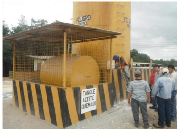
Fotografía No. 38: Bodega de desechos peligrosos
