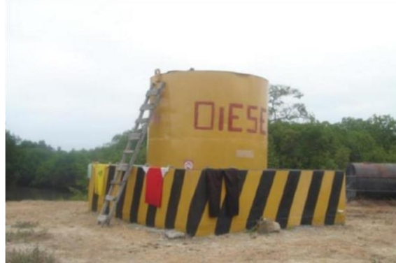
Fotografía No. 52: TK de almacenamiento 2
