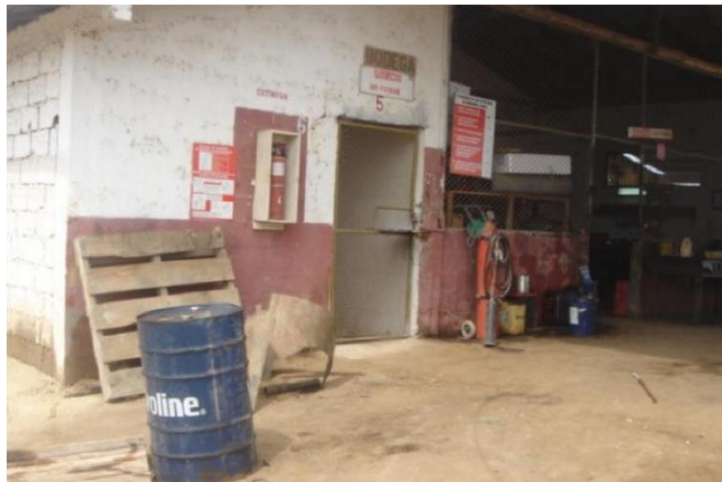
Fotografía No. 40: Bodega de químicos - varios
