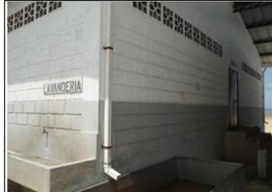
Fotografía No. 33: Vista frontal área de Baterías sanitarias
