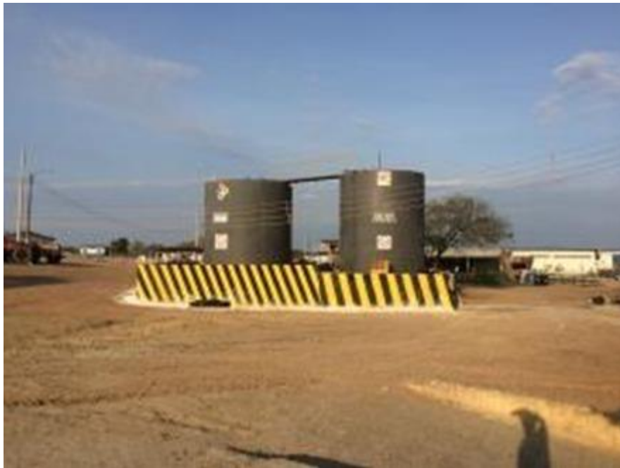
Fotografía No. 53: TK de almacenamiento 2
