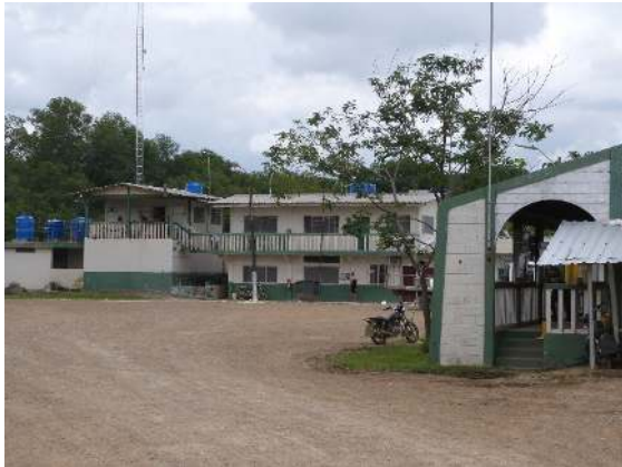
Fotografía No. 49: Campamento No.1; Oficinas administrativas.
