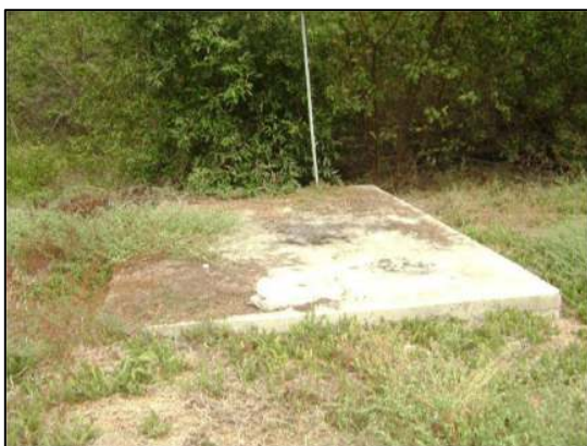
Fotografía No. 55: Vista pozo séptico
