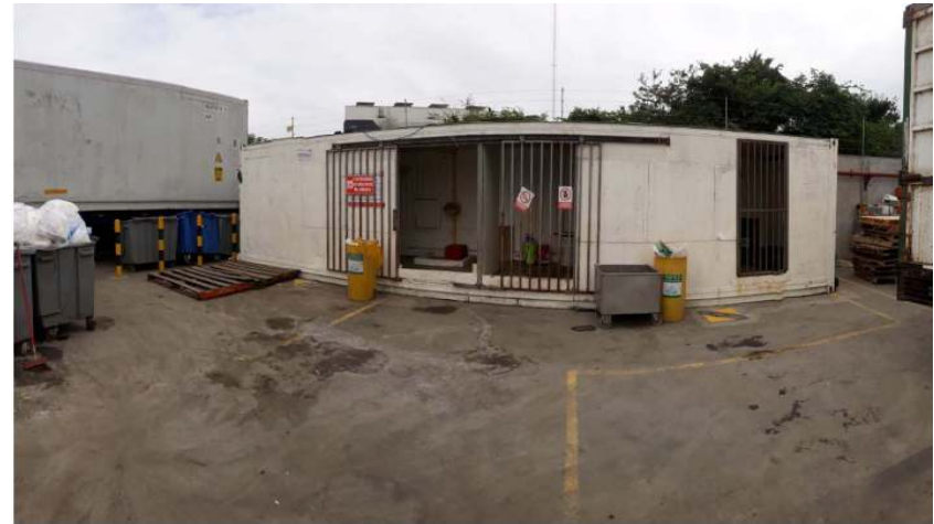
ÁREA DESECHOS PELIGROSOS
